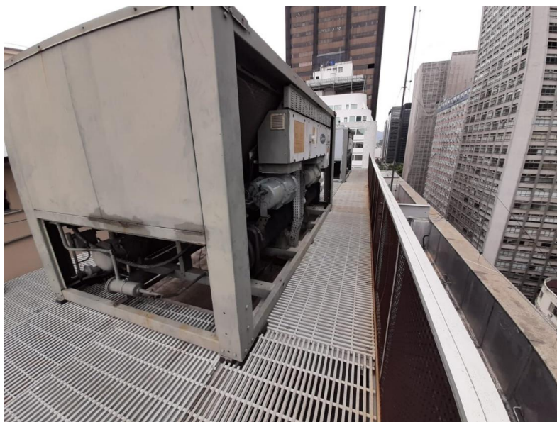
Chillers Parafuso instalados na cobertura do Prédio Av. Alm. Barroso, 78 - Centro
